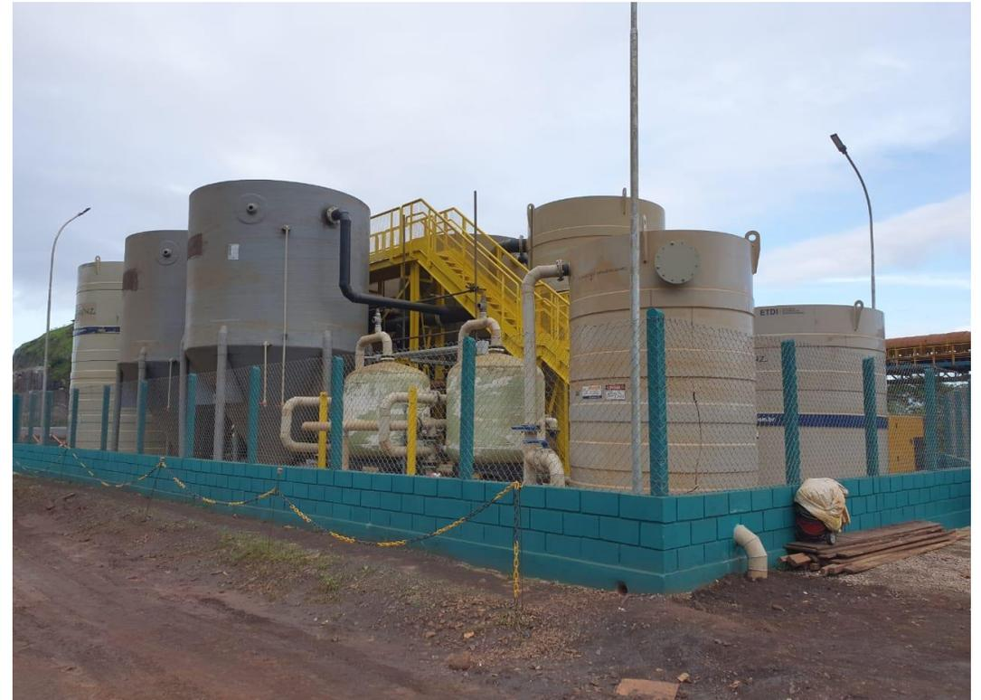
Estação de Tratamento de Efluente Pluvial – 100 m<sup>3</sup>/h
