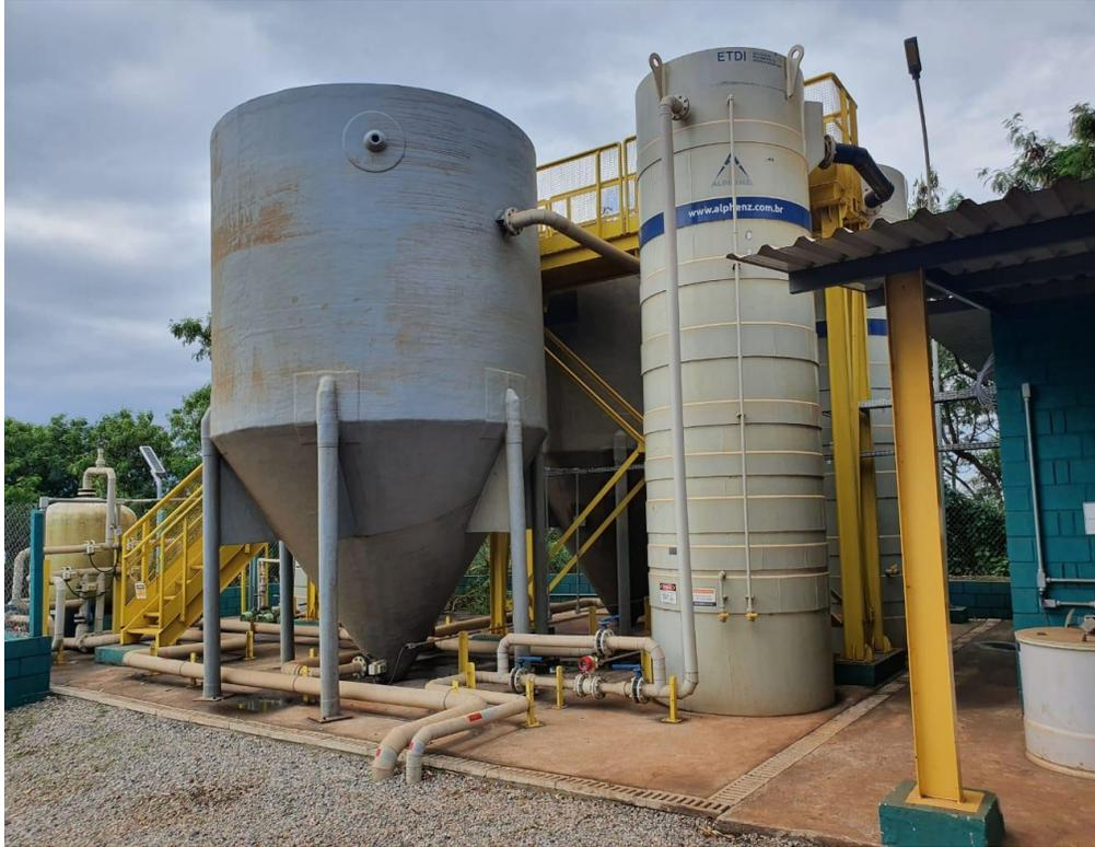
Estação de Tratamento de Efluente Pluvial – 40 m<sup>3</sup>/h
