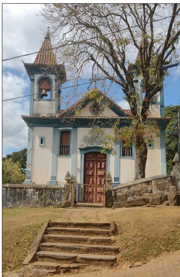
Figura 38. Vista da Igreja de Nossa Senhora do Rosário (P13).
