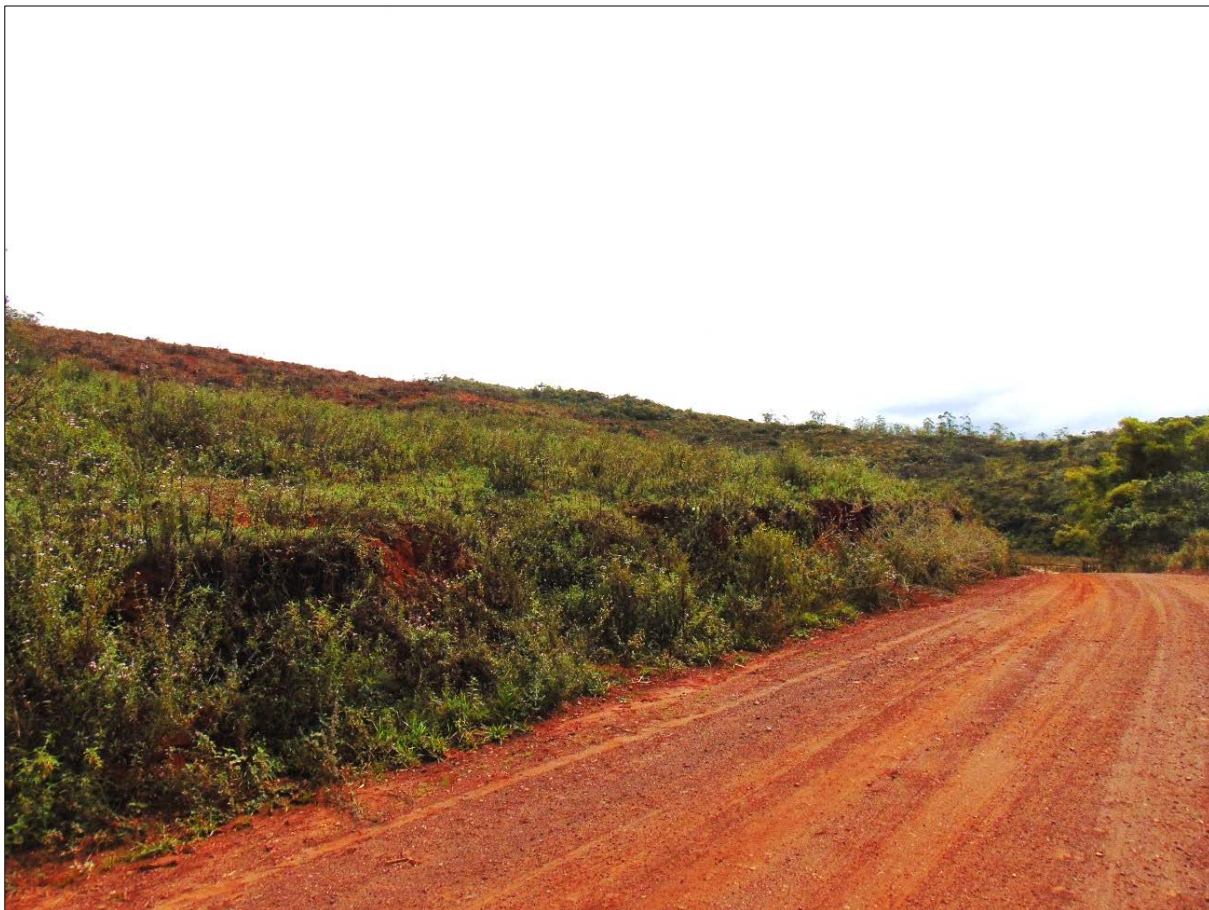
Figura 23. Área da fazenda do Piteiro, onde a supressão e as obras de retaludamento já foram concluídas (P2).
