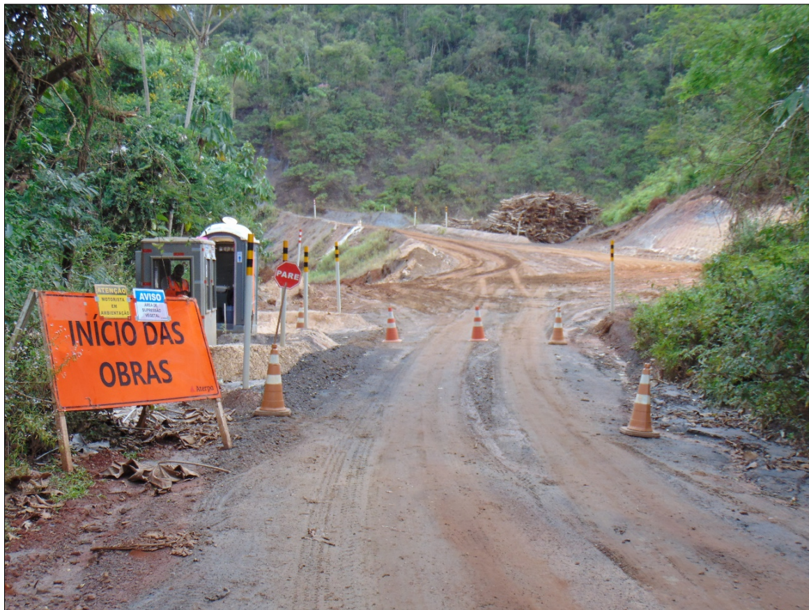
Figura 28. Sinalização informativa sobre o trecho em obras (P5).
