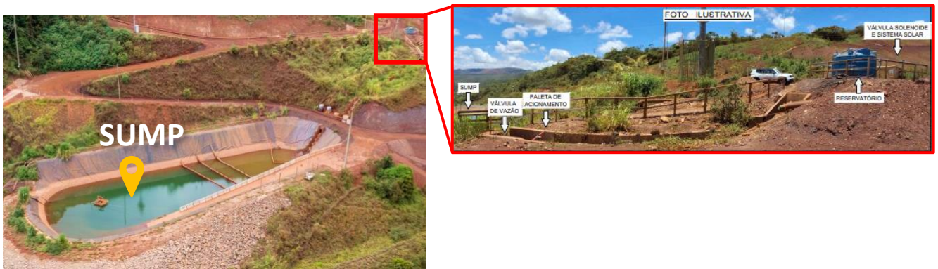
Figura 37. Sistema automatizado de aplicação de floculante. (Fonte: Vale, dezembro de 2023)
