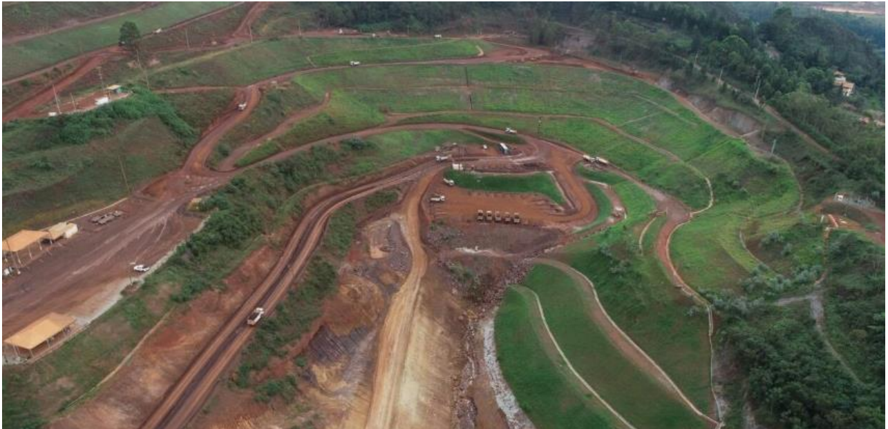
Foto 14. Vista da PDE-X após processo de revegetação bem estabelecido. (Fonte: Vale, 11 de abril de 2024).
