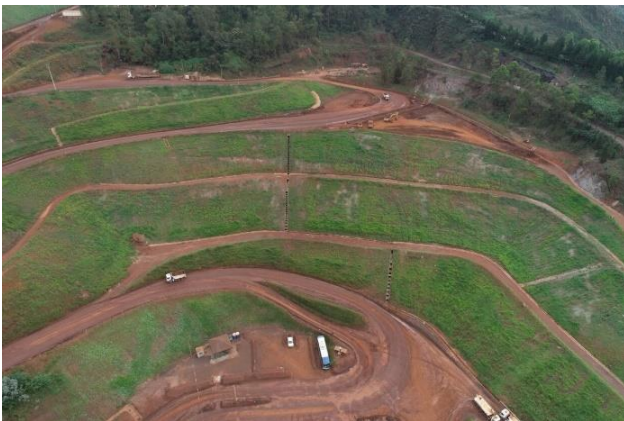
Foto 3. Canaletas e drenagens - Obras de descaracterização da barragem B3/B4. (Fonte: Vale, abril de 2024).
