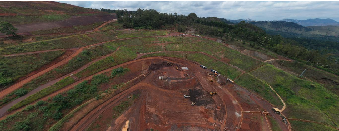
Foto 13. Vista da PDE-X após processo de revegetação bem estabelecido das ombreiras da barragem. (Fonte: Vale, 29 de janeiro de 2024).
