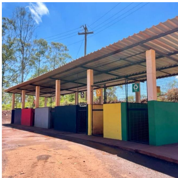
Foto 23. DIR do Canteiro. (Fonte: Vale, 2023).
