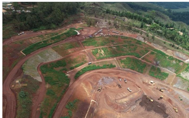
Foto 10. Vista da PDE-X após processo de revegetação (Fonte: Vale, fevereiro de 2023)
