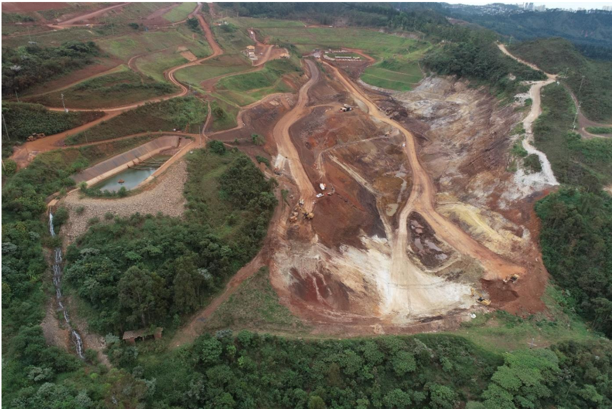
Foto 2. Execução da etapa final. (Fonte: Vale, maio 2024).
