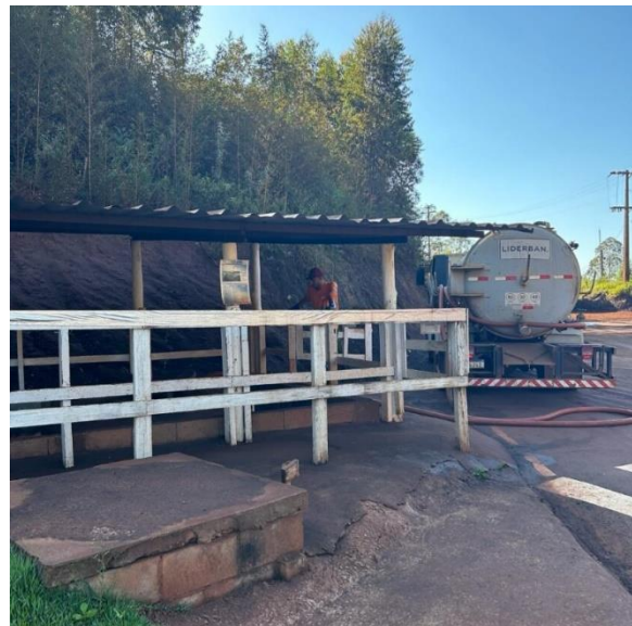
Foto 20. Higienização do tanque estanque. (Fonte: Vale, abril de 2024).
