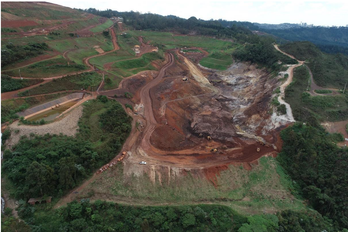
Foto 1. Execução da etapa 14 da descaracterização. (Fonte: Vale, abril 2024).
