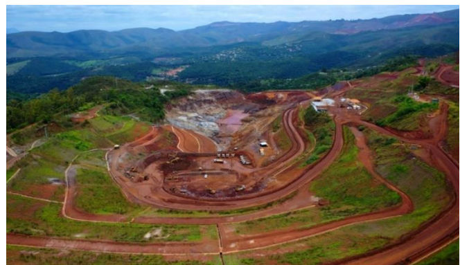
Foto 12. Vista da PDE-X após processo de revegetação bem estabelecido das ombreiras da barragem. (Fonte: Vale, janeiro de 2024)
