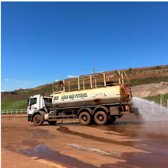
Foto 17. Umectação nos acessos - baía 04. (Fonte: Vale, abril de 2024).
