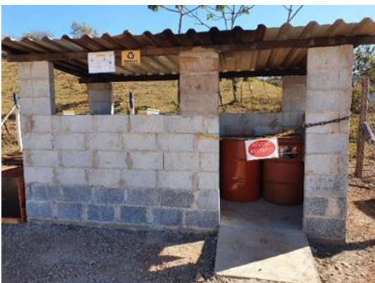
Figura 22: DIR Resíduos Perigosos (Fonte: Vale, 2022.)
