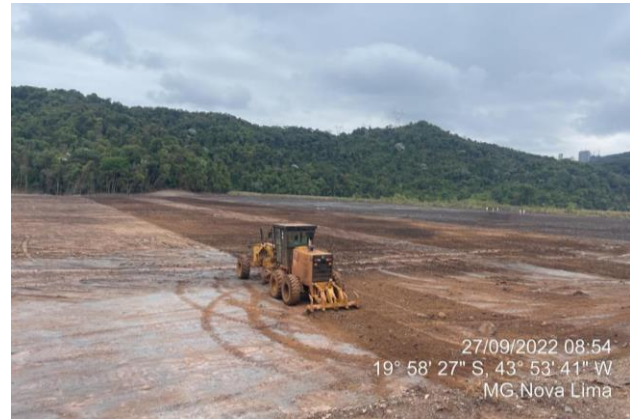
Figura 27: Escarificação do solo – Motoniveladora, em 27/09/2022. (Fonte: Vale, 2022).
