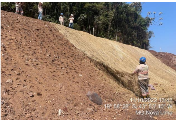
Figura 30: Aplicação da Biomanta, em 11/10/2022. (Fonte: Vale, 2022).
