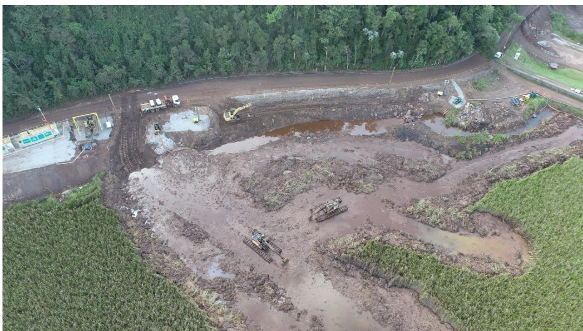
Figura 2: Imagem do projeto em 19/05/22, ilustra a tentativa de execução da Vala 01 da concepção original.
