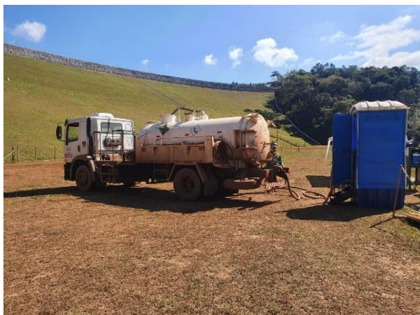
Figura 16: Limpeza dos banheiros hidráulicos (Fonte: Vale, 2022.)
