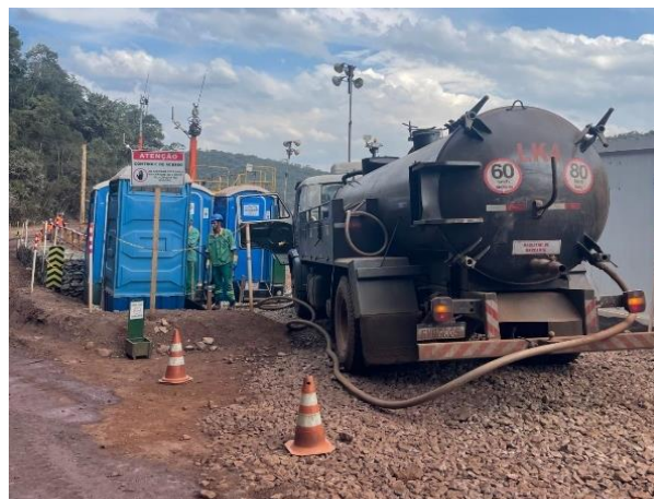
Figura 17: Limpeza dos banheiros hidráulicos (Fonte: Vale, 2022.)
