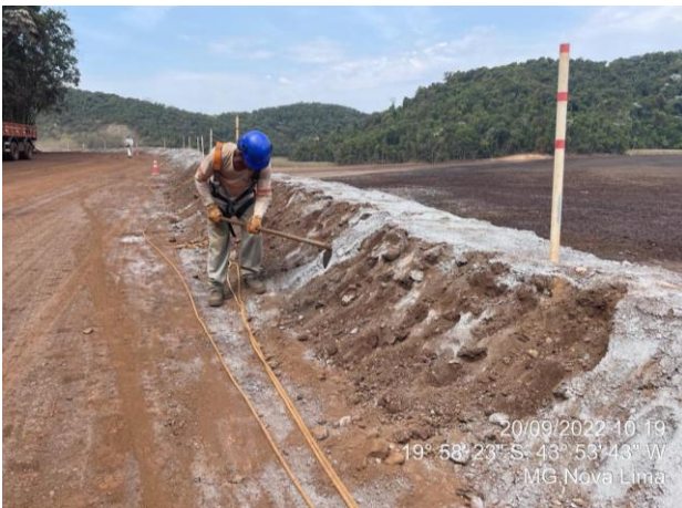
Figura 28: Coveamento manual. (Fonte: Vale, 2022).
