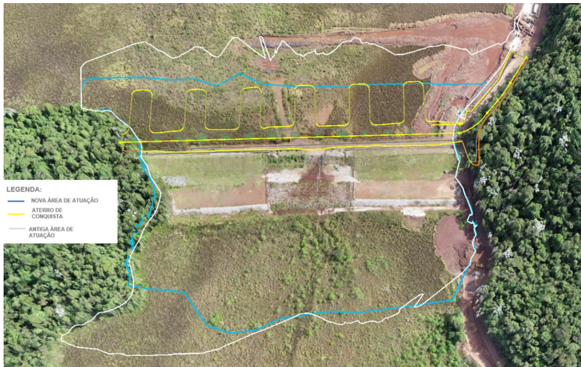
Figura 3: Imagem do projeto em 19/05/22, ilustra a tentativa de execução da Vala 01 da concepção original.
