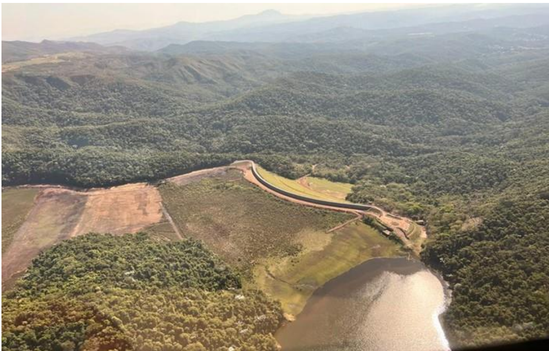
Figura 10: Dique Auxiliar B5 descaracterizado (15/09/22).
