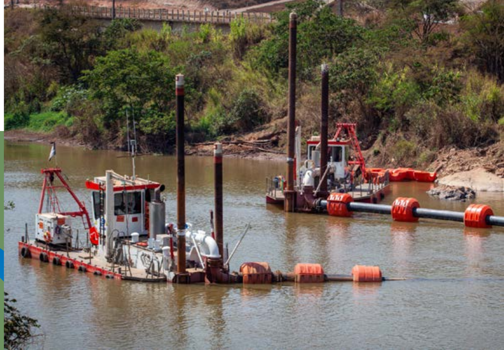
Visão geral da dragagem do rio Paraopeba. Foto: Vale
