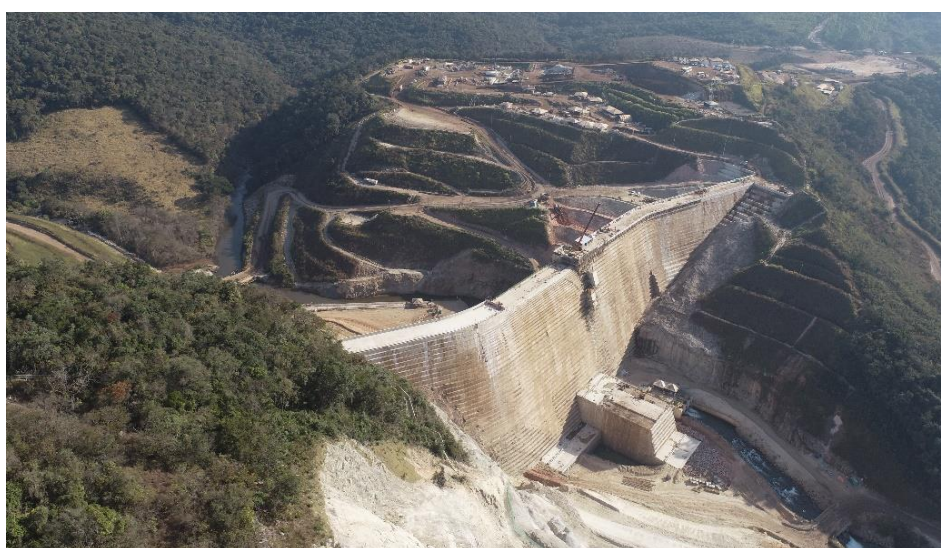
Figura 4-8 - Vista de jusante da ECJ Mina de Fábrica, com detalhe do reforço dos blocos 9 e 10 (DF+, 2021)
