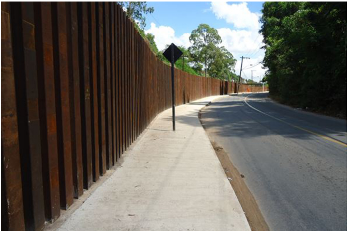
Muro antes de receber a intervenção artística
