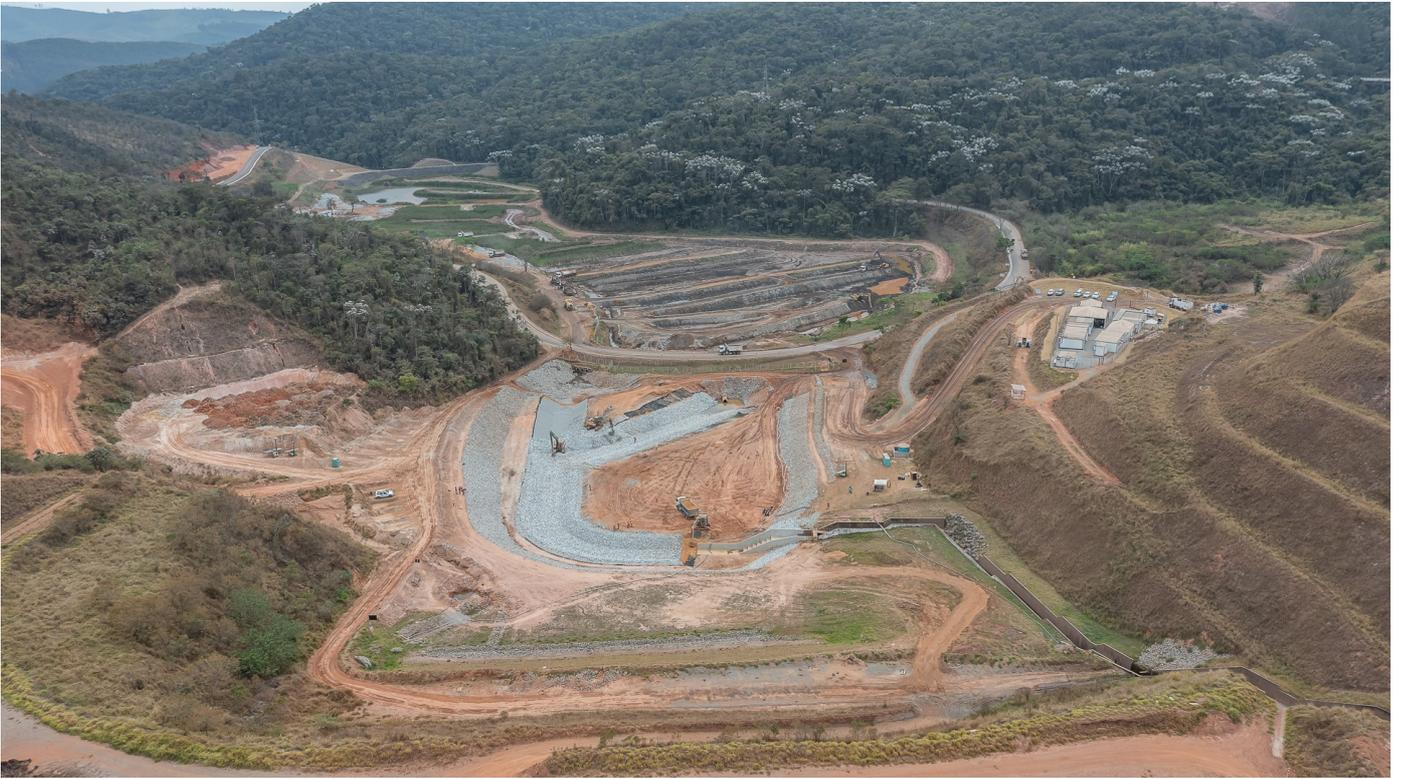
Barragem Ipoema, na Mina do Meio, em Itabira (MG), teve sedimentos do reservatório completamente retirados
