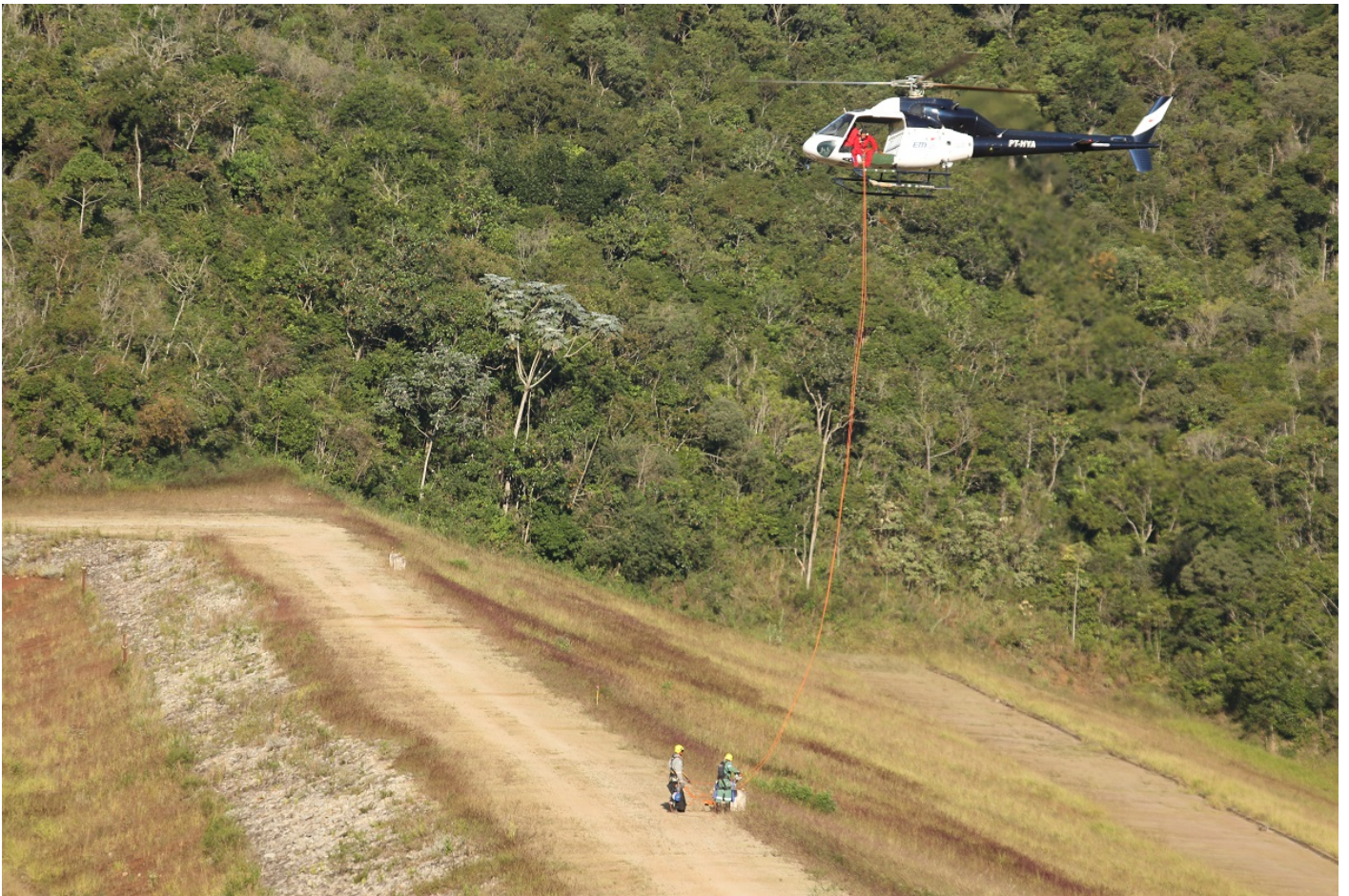
Descida de rapel na barragem Sul Superior
