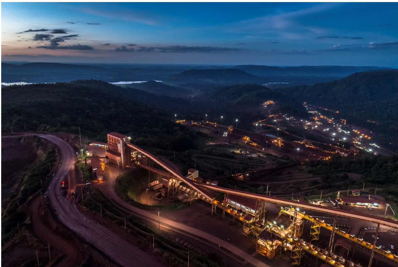
Visão noturna da usina na mina de Carajás
