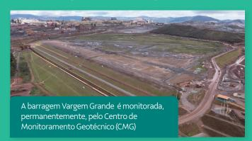
Começamos a remoção gradual dos rejeitos da **barragem Vargem Grande,** da mina Abóboras, em Nova Lima. O trabalho ocorre em uma das etapas do projeto de descaracterização. A barragem passou por testes de vibração e, desde 2019, recebe ações
