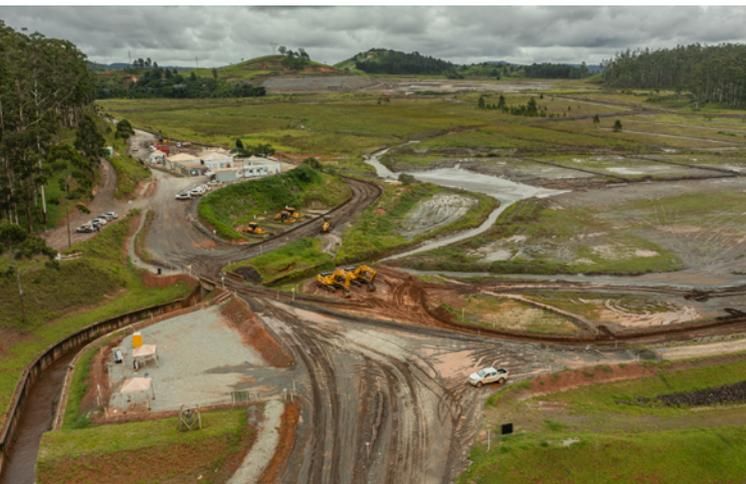
A conclusão das obras de eliminação do **Dique 2 da barragem do Pontal**, localizado em Itabira, será antecipada de 2024 para 2023. A antecipação é resultado de avanços de engenharia nas obras preparatórias de descaracterização da estrutura e dos aprendizados adquiridos na eliminação dos diques 3 e 4, cujos projetos são semelhantes.
